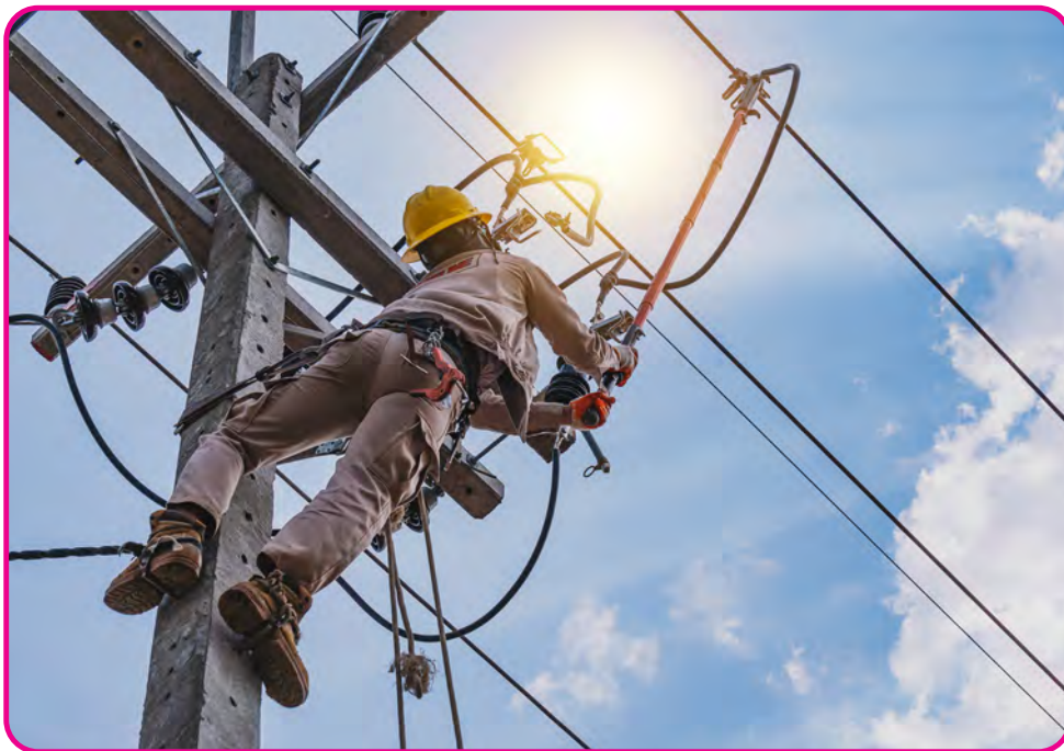
Görsel 1-Elektrik direğinde çalışan işçi
